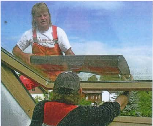
Dann reicht Michael Kremser seinem Kollegen die Alukassette nach draußen, in der sich der Rollladen befindet.
