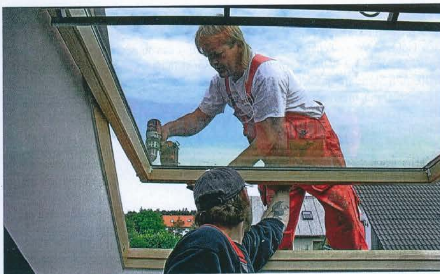
Bevor Günter Diepold den Aufsatz des Solarrollladens außen montieren kann, muss er die bestehende Unterkonstruktion des äußeren Fensterrahmens abmontieren. Sein Kollege Michael Kremser (vorne) ist dabei unterstützend tätig. Fotos: Pätzold
