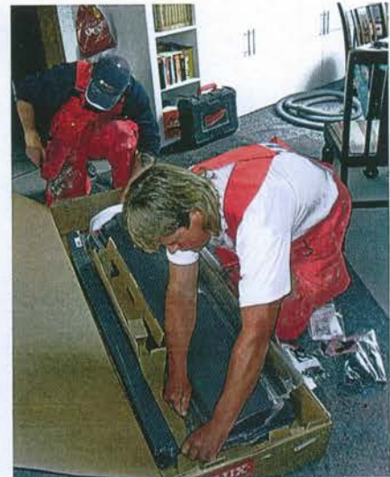
Bevor es mit der Montage richtig losgehen kann, müssen die in Folie eingeschweißten Einzelteile ausgepackt werden.
