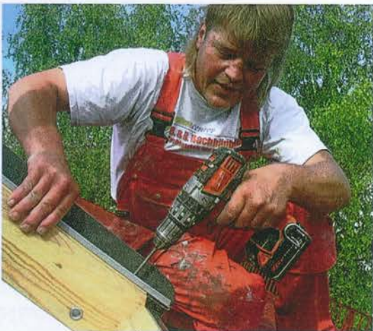
Schritt für Schritt schraubt Bauschreiner Diepold dann die Unterkonstruktion des Solarrollladens an.
